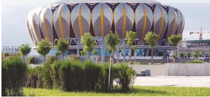
百灵庙城镇风貌区
